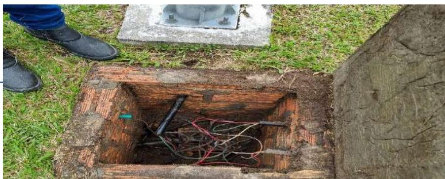
Em uma das caixas encontramos água no fundo, o que pode acarretar indução eletromagnética no circuito elétrico, podendo comprometer o funcionamento dos componentes ao circuito interligado.
