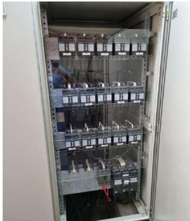
Apesar de apresentar funcionamento normal, não podemos deixar de sugerir a realização de manutenção preventiva dos contatos e condutores, bem como, salientar que atualmente existem no mercado disjuntores tipo DRs com maior performance e maior nível de proteção dos circuitos elétricos e conseqüentemente das instalações como um todo.
