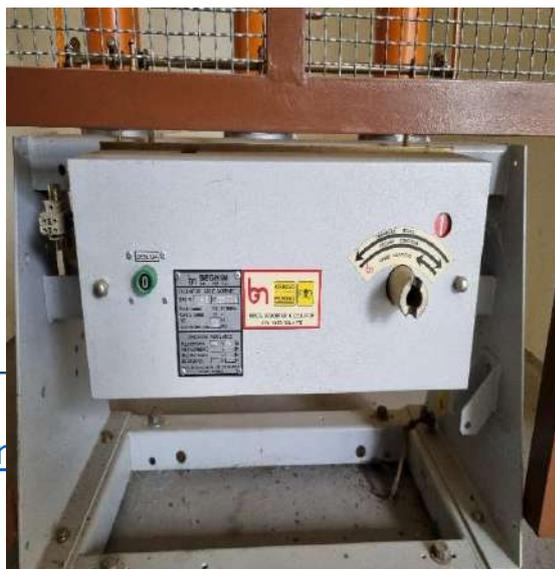
As imagens acima é o disjuntor PVO, que poderá ser modernizado, sendo substituído por Disjuntor à vácuo, reduzindo inclusive índice de manutenção.
