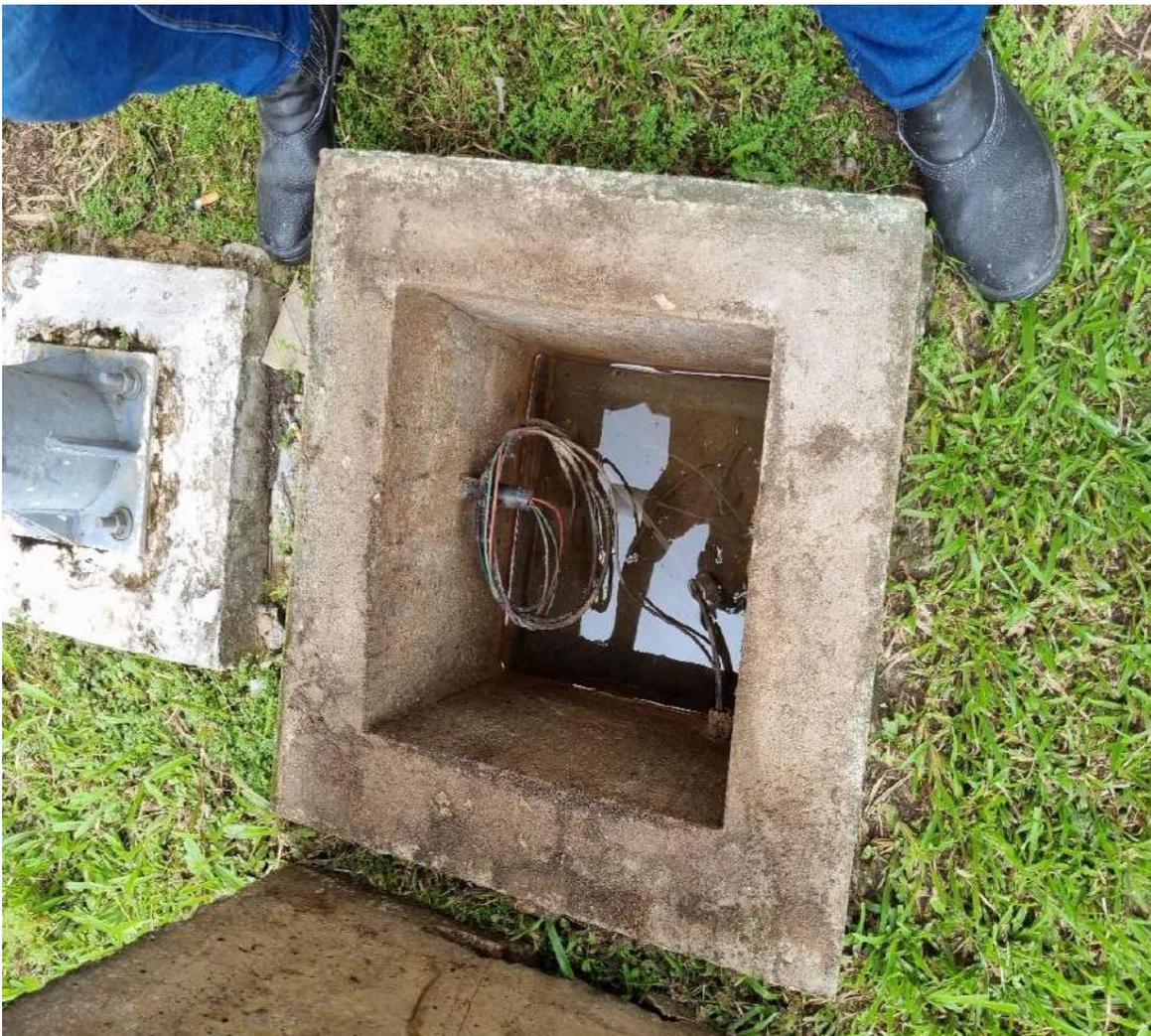
Sugerimos nesse parecer que o excesso de barro seja retirado do interior das caixas, bem como a água seja drenada, prezando bem bom funcionamento das luminárias externas e demais componentes interligados nestes circuitos.
